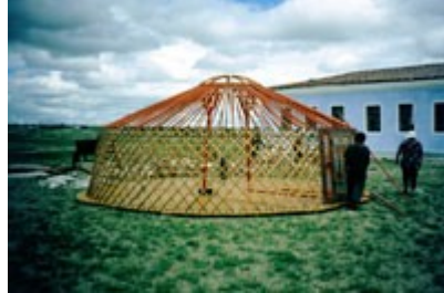
Una GER in costruzione
